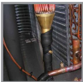
La batteria è stata realizzata a circuiti differenziati (i circuiti non hanno tutti la medesima lunghezza, ma dipendente dal coefficiente di scambio termico) per massimizzare lo scambio termico in funzione della distanza dal ventilatore.
